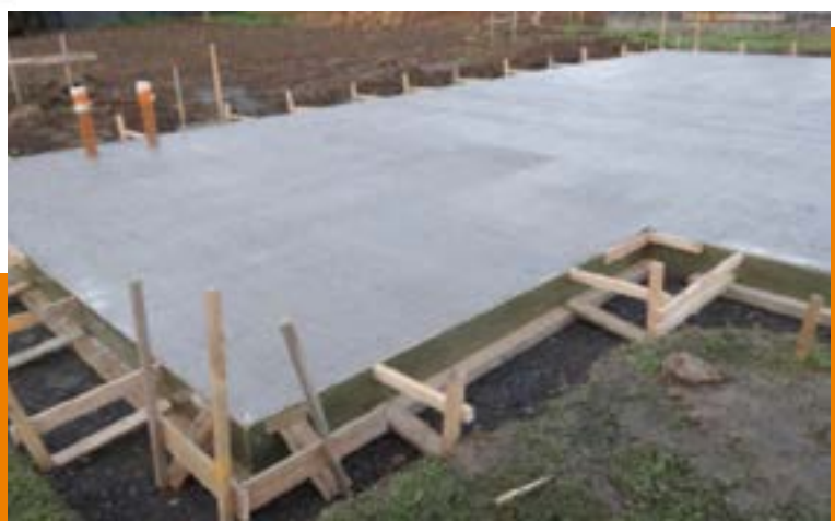
Radier o losa de hormigón como base de cimentación para casas prefabricadas fijas.
